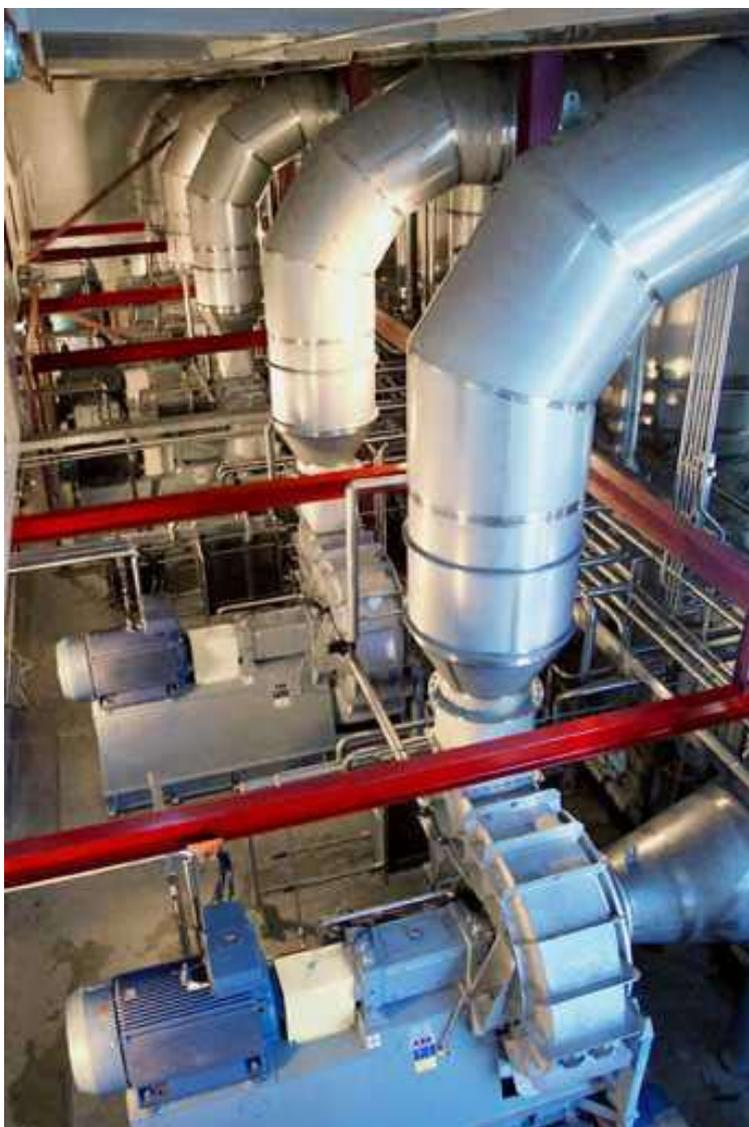
6 вентиляторов высокого давления для двух выпарных аппаратов с полным тепловым насосом
