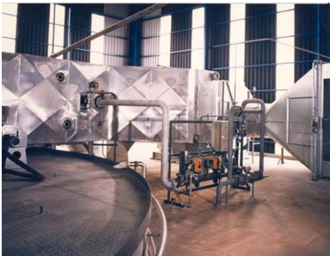
Контактный нагреватель воздуха с газовой горелкой
